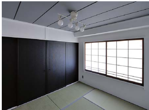
▲和室。既存畳表替えと、塗装のみのシンプルな改修とした。
