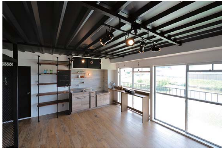
▲既存間仕切りを取り払い、広い一室としたLDK。天井は角波トタン張り、床はヴィンテージ加工フロアタイル。キッチンには杉板を張り、カウンターとガス管の棚を製作。
