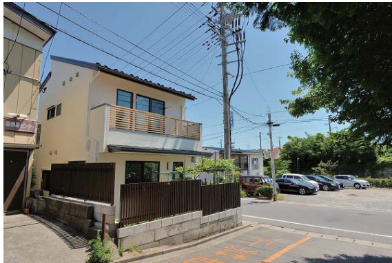
敷地南西から見る。8mの前面道路と仙石線が走る土手が見える。
