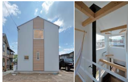
道路側ファサード。家型のアイコンとしてデザインしている。吹抜け、窓は南東に、北東側は街の遠景が見える
