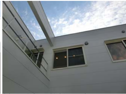
中庭から見上げる。2階個室とルーフトバルコニー。
