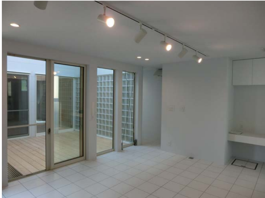
アトリエ。中庭を介してLDKと対面する。床はホワイトのPタイル、壁・天井はホワイトのEP塗装仕上げ。
