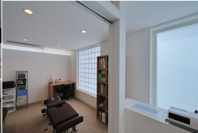
待合室・受付カウンター側から施術室を見る。床仕上げはタイルカーペット敷き。内部全体を土間コンの直床から乾式二重床に改修し、快適性の向上を図っています。
