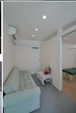
待合室。カーテンだった間仕切りを木製建具としました。
