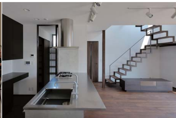
「宮城野の現代和風」のスチール階段。リビングに開放された折れ曲り階段です。全体を和風としてまとめ、家具や建具のインテリアに合わせてダーク・ブラウンの塗装を施しました。
