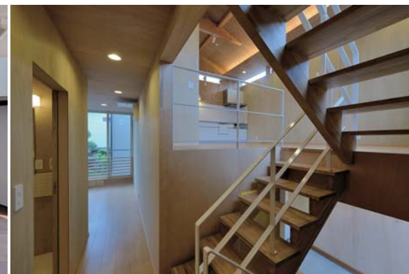
「霊屋下のスキップ」の木製の力桁階段。スキップフロアで、東西方向に半階ずつ昇降します。手摺はFB スチール製ですが、木質系のインテリアともよくマッチしています。
