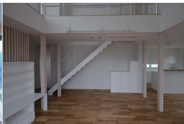
「高野原の住宅」のリビングのストレート階段。フラットなスチールの側桁により支持され、安全に配慮しながら見た目もスッキリとシンプルにデザインされています。
