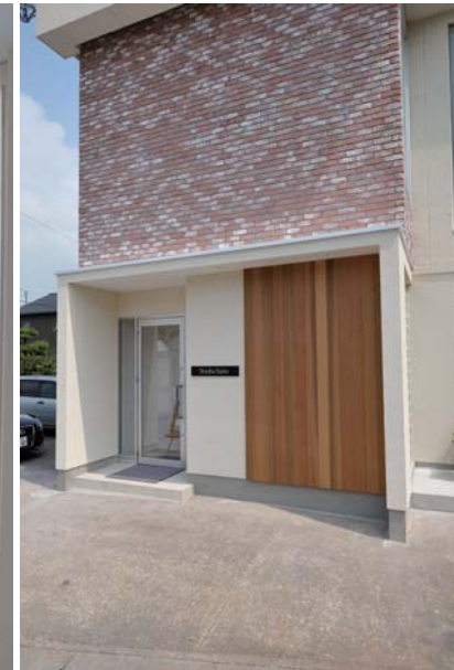
西側ファサード。インテリアと同素材のレンガ壁。1 階部分は塗壁とベイスギのコンビネーション。夜間は LED 照明で照らし出される。
