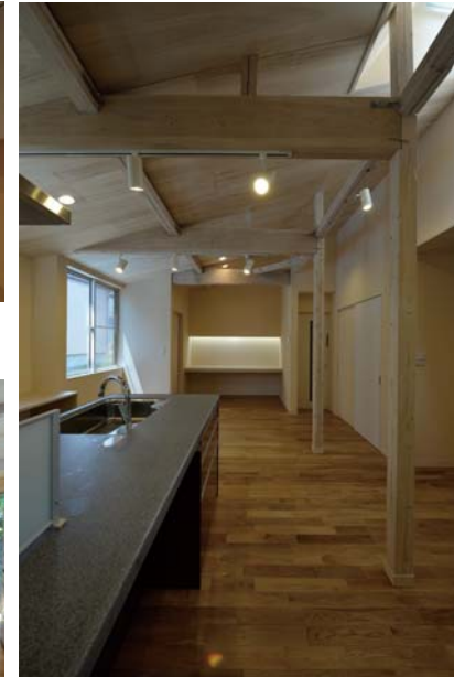
キッチン。既存の構造体が露出している。上部にはトップライトを設け奥まった位置に陽を取り込む。
