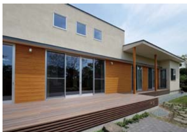
南面の川側に面するデッキ。樹種はセランガンバツで極めて腐食しにくい。
