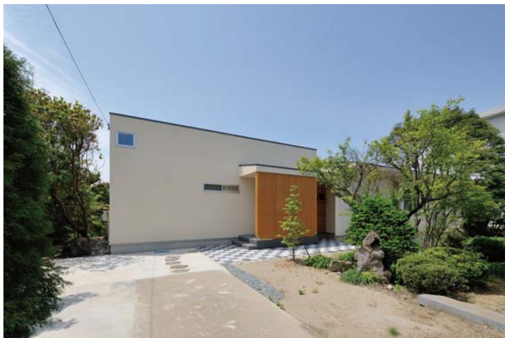
北側アプローチとファサード。ルーバーの横から玄関に入る。塗壁の壁面は北側ということもあり比較的閉じた表情を持つ。
