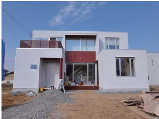
南面ファサード。ガルバリウム鋼板サイディングと米スギナノルディックレッド木材保護塗装の外壁。
