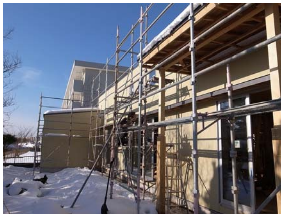
住宅南側、庭を介して川に面します。中間領域であるデッキの出は、2,300ほどあり、1,600程度の軒がかけられます。
