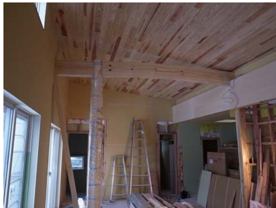
リビング・ダイニング、屋根なりに傾斜した天井と、インテリアの中心になる柱・梁が表しになります。
