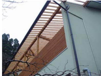
ルーフバルコニー。透明ポリカーボネート製の屋根。
