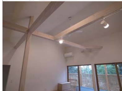
斜め天井の中に構造体が現れ、明るく開放的なLDK。
