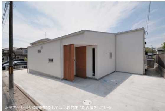
東側ファサード。道路側に対しては比較的に閉じた表情をしている。
