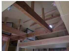
構造補強工事。複雑な構造体と取り合う天井仕上工事で、大工さんは大変苦労したようです。
