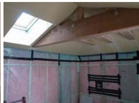
寝室の断熱・気密工事。大変丁寧な作業をしていただきました。
