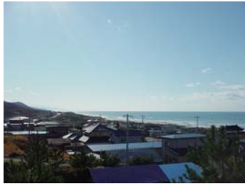
海を望める丘の上に建設中。
