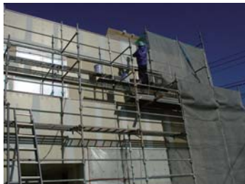
吹き付け塗装工事中。
