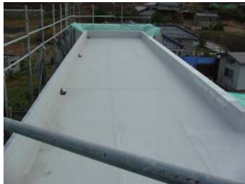
屋上は防水フラットルーフ。
