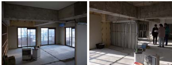
仕上り間仕切りを解体し、一旦スケルトンの状態とした現場。
