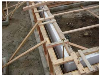
基礎型枠検査。 アンカーボルト
