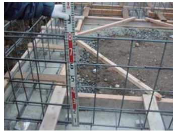
基礎配筋検査。
