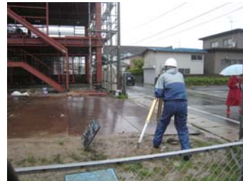
建て方検査で、トランシットを覗く加藤。ドシャ降りの雨の中、慎重にチェックします。
