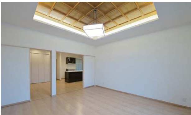
▲既存の木製天井の周囲にはLEDの間接照明を仕込み、記憶を継承すると共に、新たなデザイン要素として取り込んだ。
