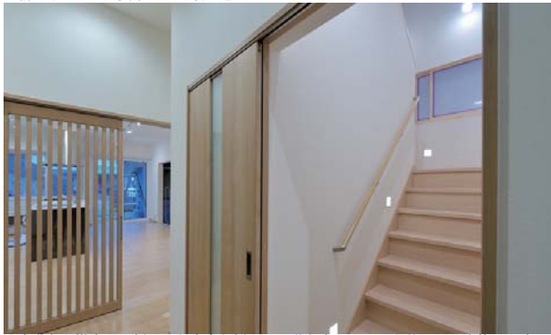
▲直階段を撤去し、新設した安全な折り返し階段室。ホールと仕切り、吹抜けも床で塞いだ。
