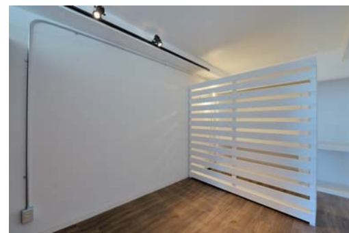
寝室からWICを見る。板張りの収納家具は、入居者に合わせて寝室と収納スペースの調整ができるように可動式とした。
