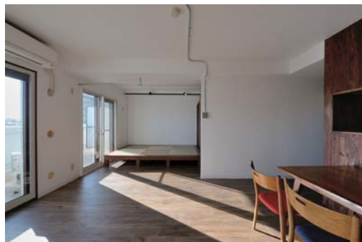
メタルな素材使いで統一した、トグルスイッチ・配線用の露出銅管・ガス管の物干しバー。鈍く光る材質が、他にはない独特な存在感を放つ。
