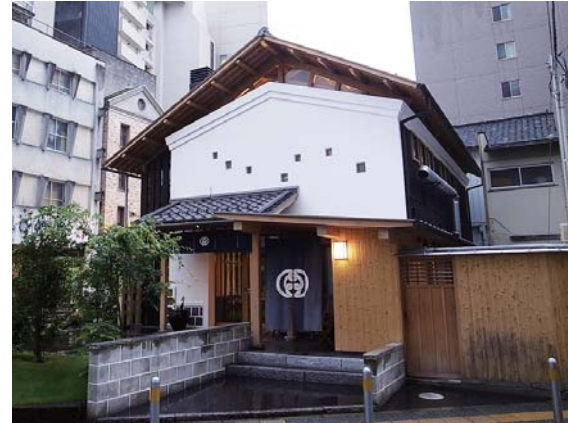
■玄孫 仙台市青葉区本町の山形県より古い蔵を移築した飲食店。市街地に移築するにあたり、防火上多くの難解な法規をクリアしている。
