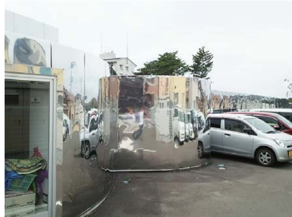
■宮城県七ヶ浜町 七ヶ浜町立遠山保育所 中庭を囲う空間構成。外周面の全面に張られたステンレス板が、周囲の風景を歪ませて映し込み、非日常的景観を生み出している。
