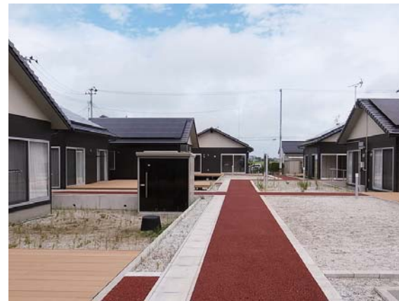
■宮城県岩沼市 岩沼市玉浦西災害公営住宅 B-1 地区 住戸間を縫うように配置された「緑道」等、強い信頼関係があつてこそ成立する構成が、強固なコミュニティを生み出している。
