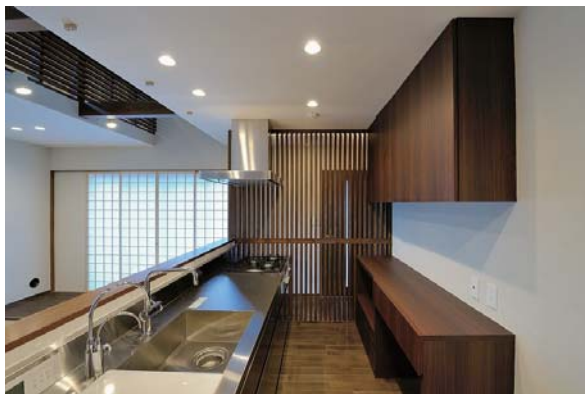
「青葉 Ym-House Renovation」 壁付タイプのステンレスキッチンに、手元を隠し食事が可能なカウンターを現場施工している。背面収納は上下セパレート造作タイプの収納棚で、ルーバーも合わせてカラーコーディネートしている。
