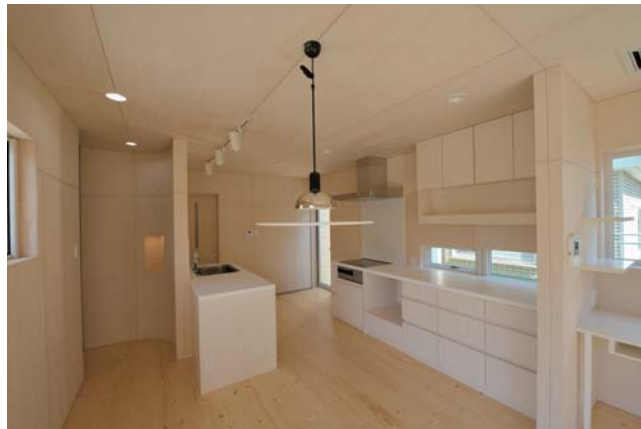
Kz-House：フルオーダーの製作キッチン。シンク部とコンロ部を分離してそれぞれ収納を兼ねたキャビネットに組み込んでいます。キャビネット自体がデザインされ、他の造作家具とコーディネートしています。
