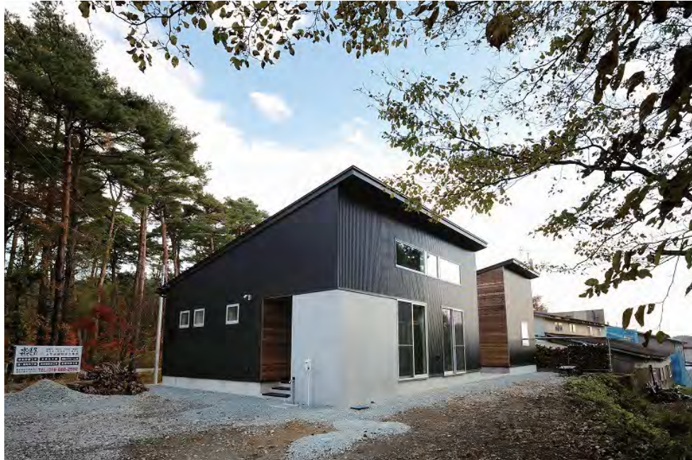
▲北西から見る。周辺は緑が多く西側には窪地状の雑木林が広がります。外観は黒を基調とした周囲から浮き上がらないような配色としています。
