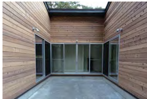
▲コート内部。左手はLDKのパブリック、右手は個室のプライベート。
